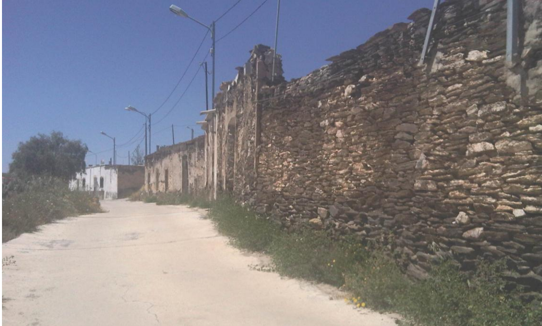
Foto 4. Vista de calle La Iglesia.
